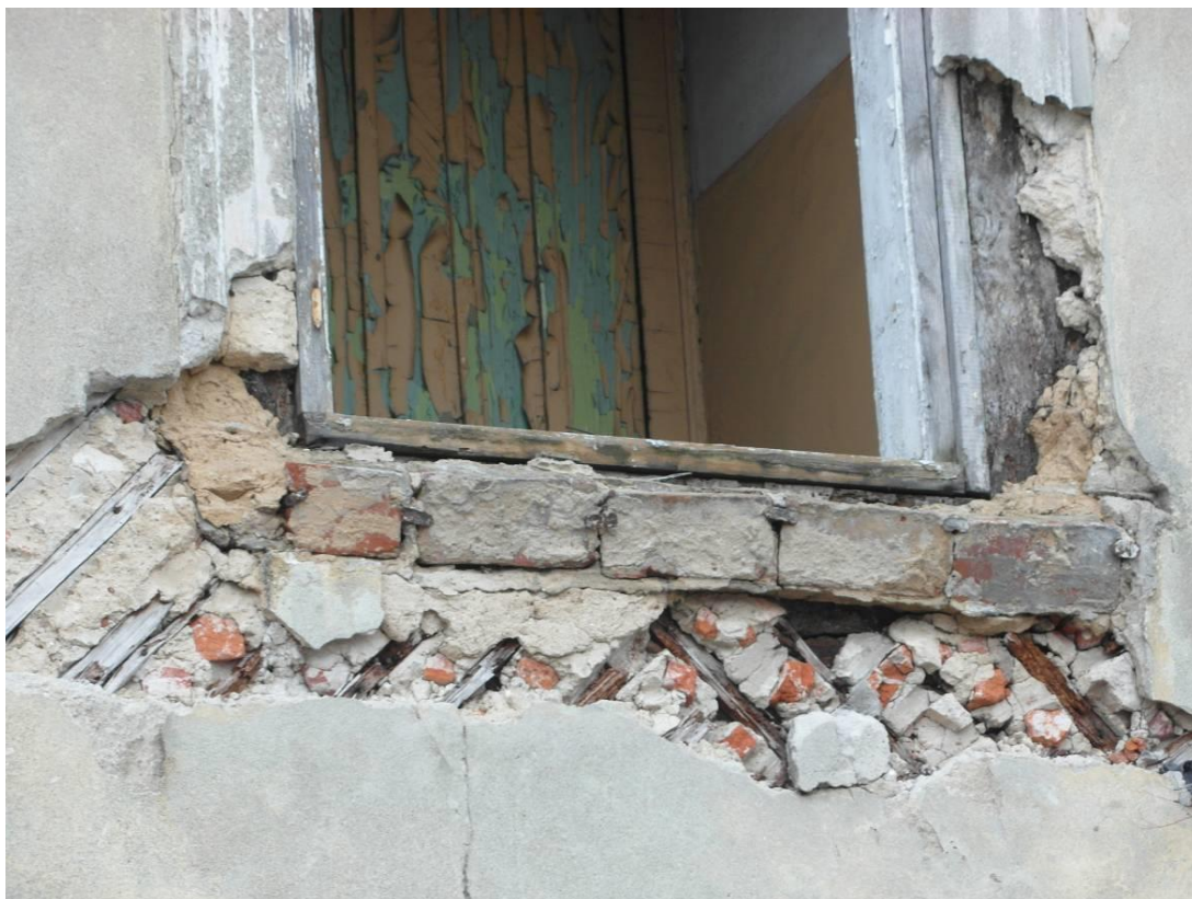
Widok ścian pierwszego piętra ze zróżnicowanymi wątkami pasm murowanych i pasm sumikowo-łatkowych
