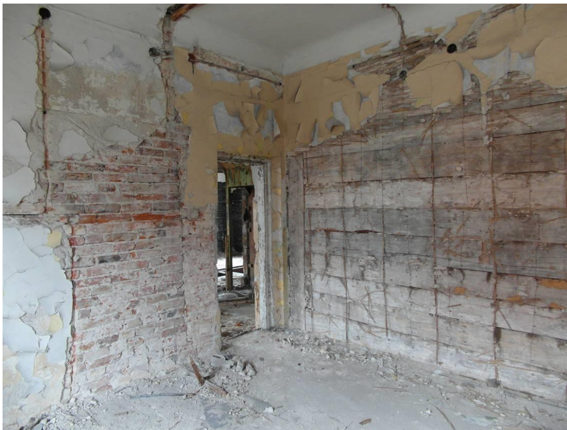
Widok konstrukcji sumikowo-łatkowej ścian zewnętrznych pierwszego piętra budynku po usunięciu warstwy tynku wapiennego.
